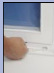
Inåtgående överfalsade fönster kontrolleras lättast med en spegel.
