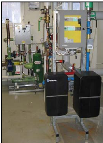
Bild 1: NordIQ fjärrvärmecentral
